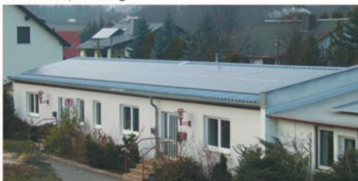
Die vorhandenen Dachflächen waren günstig nach Süden ausgerichtet. Nach gründlicher Analyse und Planung konnten auf den Dachflächen drei Photovoltaikanlagen mit einer Gesamtleistung von 76 kWp montiert werden. Es sind monokristalline Module mit einer Leistung von 170 Wp verbaut worden.
