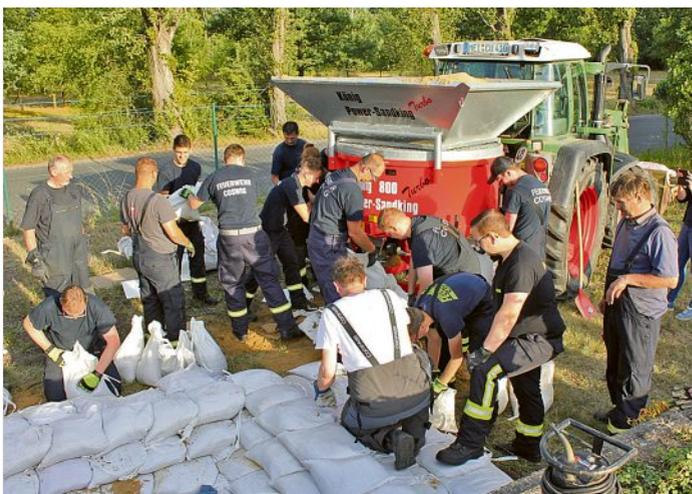
**Kameraden und Sandsackfüllmaschine in Aktion**
